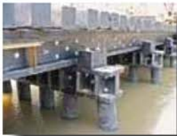
• استخدام ايزوبنت حول ركائز البناء
